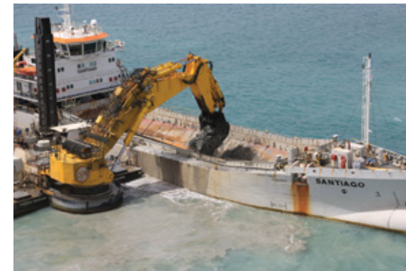
Figura 3: Draga mecânica retroescavadeira
